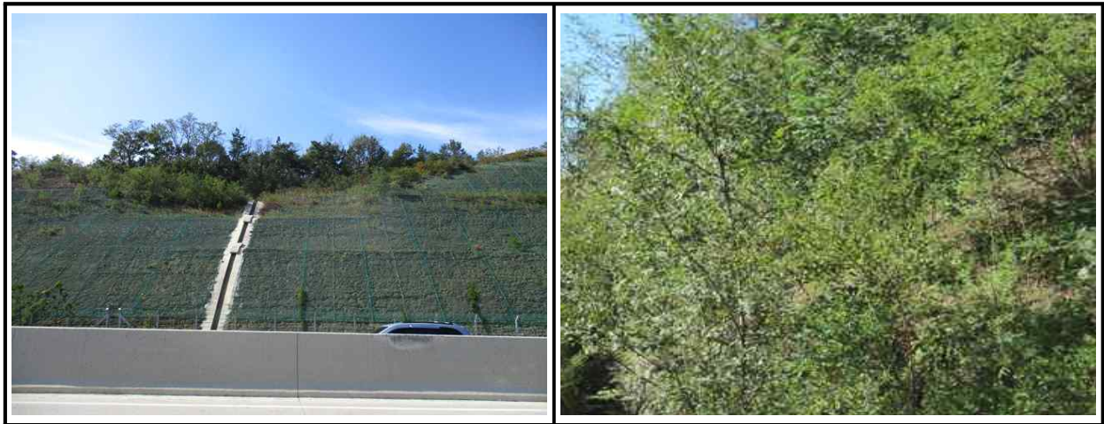
【그림 66.3.1】 상부자연사면 전경
