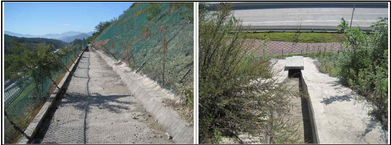
【그림 66.3.3】 배수시설 전경
